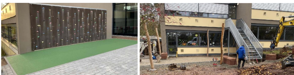
Bilder: Der Fallschutz der Kletterwand ist neu gemacht. Die Terrasse des Ganztagesbereichs ist gepflastert. Die Pfosten für das Sonnensegel stehen.
