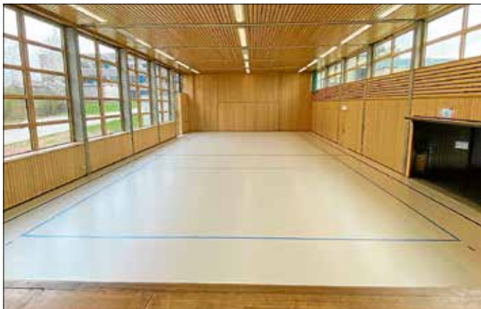
Sanierter Hallenboden der Turn- und Festhalle Neubulach
