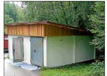
Klärwärterhäuschen Kläranlage Liebelsberg
