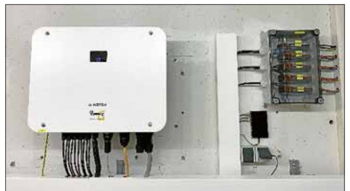
Wechselrichter mit Verteilung
